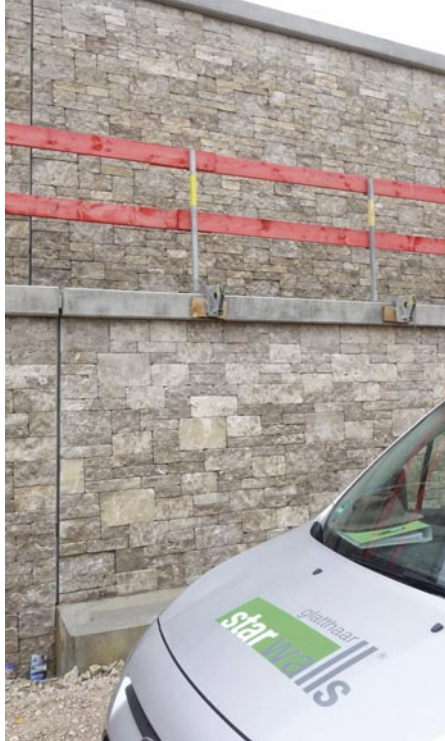
Teilweise zweireihige Böschungssicherung, bei der eine Rückverankerung nicht erforderlich ist. Umgerechnet auf die nach Fertigstellung vorhandenen 2320 Quadratmeter Sichtfläche mit Dolomit-Naturstein, liegt der geschätzte Kostenvorteil, basierend auf Regelpreisen, bei zirka 2,9 Millionen Euro – und dies bei schnellerem Bauverlauf.
