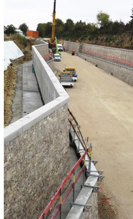
Teilweise zweireihige Böschungssicherung, bei der eine Rückverankerung nicht erforderlich ist. Umgerechnet auf die nach Fertigstellung vorhandenen 2320 Quadratmeter Sichtfläche mit Dolomit-Naturstein, liegt der geschätzte Kostenvorteil, basierend auf Regelpreisen, bei zirka 2,9 Millionen Euro – und dies bei schnellerem Bauverlauf.
