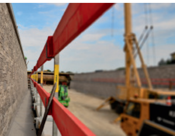
Abbildung 2: Die Mauerelemente werden zentimetergenau auf dem vorbereiteten Fundament abgesetzt.
