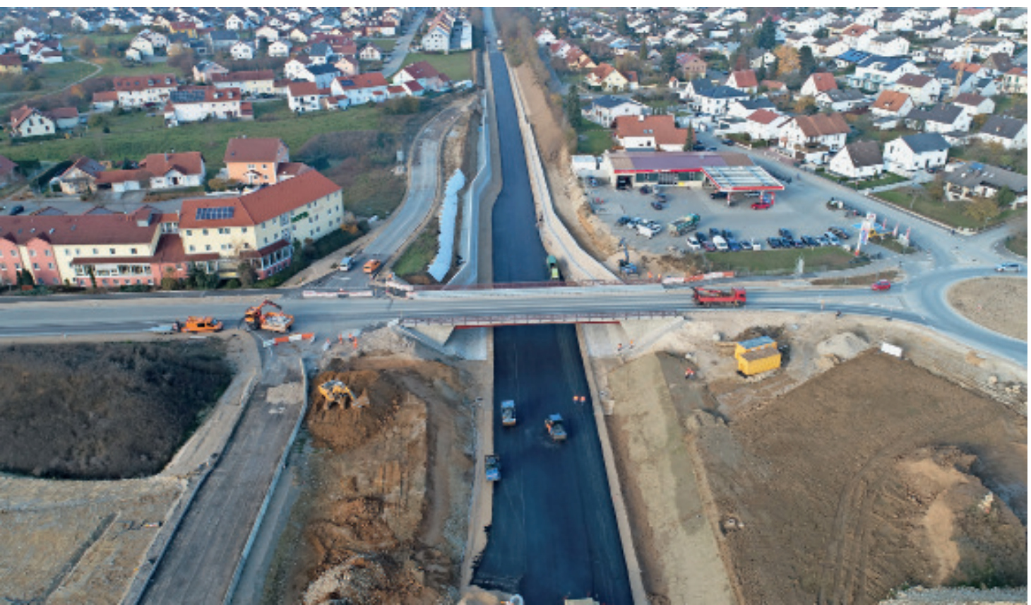
Abbildung 1: Bei der Höhenfreimachung ergaben sich durch das Verwenden Naturstein-gebundener Stützwände aus Fertigteilen ein Zeitgewinn sowie Einsparungen in Millionenhöhe.
