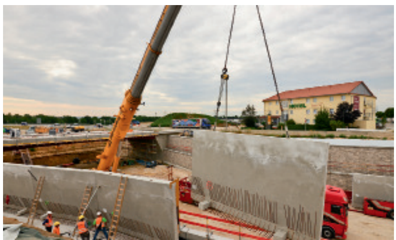
Abbildung 3: Die Anschlussbewehrung der Stützwandelemente wird mit der Bewehrung im Fundament vergossen.
