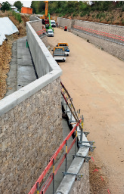
Abbildung 4: Teilweise 2-reihige Böschungssicherung, bei der eine Rückverankerung nicht erforderlich ist.
