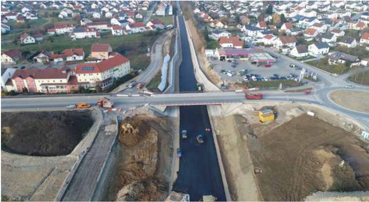
Quelle: Staatliches Bauamt Ingolstadt
