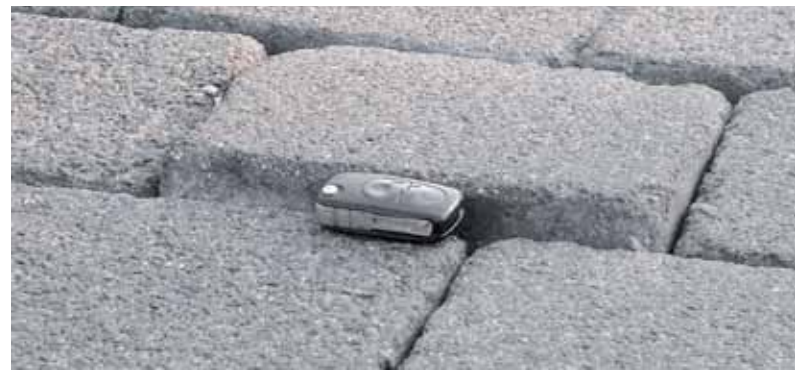
Angehoben: Das alte Fugenmaterial hat in Petersberg bis 2009 zu Problemen geführt.
