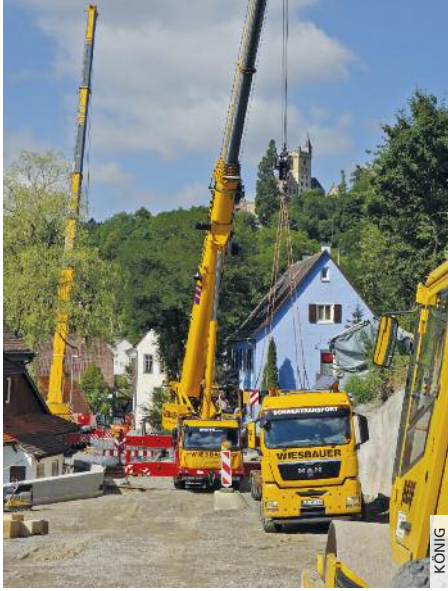
Horb-Mühringen: Ortszentrum vom oberen Teil der L 395 aus gesehen. Der Autokran hebt eines der Fertigteile vom Lieferfahrzeug auf das Fundament.
