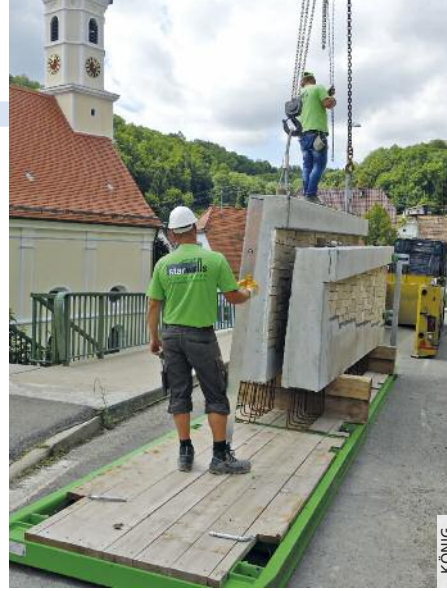
Horb-Mühringen: Auf Innenlader-Paletten werden die Mauerelemente per Lkw geliefert und beim Anhängen an den Autokran zentimetergenau justiert.
