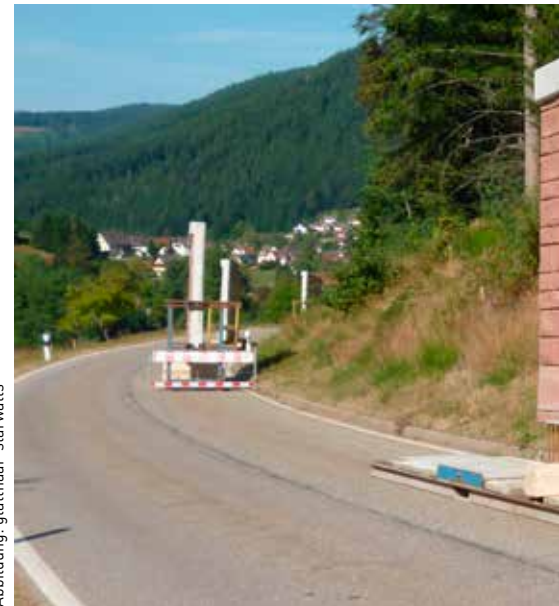
Klosterreichenbach, L 409: Lieferung der Fertigteile auf Innenlader-Paletten. Die Anschlussbewehrung an der Unterseite der Stützwandelemente wird mit der Bewehrung im vorgefertigten Fundament vergossen.
