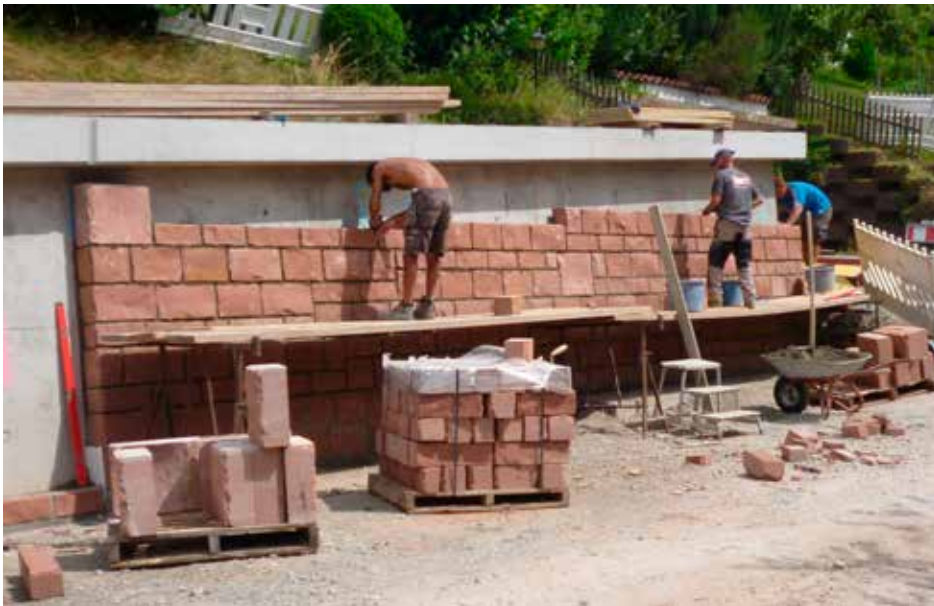
Klosterreichenbach, L 409: Verblendung der Stützmauer innerorts in herkömmlicher Bauweise. Betonieren und Verblenden mit Naturstein sind Arbeitsschritte, die nacheinander erfolgen. Das mehrfache Anliefern der Materialien und Bereitstellen des Personals verursacht einen zusätzlichen Aufwand schon bei der Planung des Bauablaufs.
