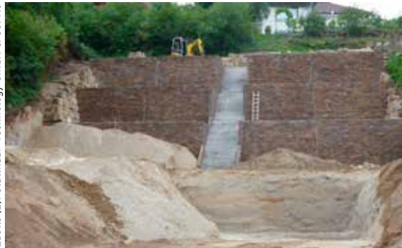
Hangstütze in drei Etagen mit Fertigteilwänden aus Stahlbeton mit Natursteinvorsatz.
