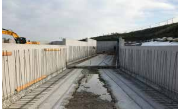
Sichtbeton Fertigteilwände mit Anschlussbewehrung für einen Recyclinghof.
