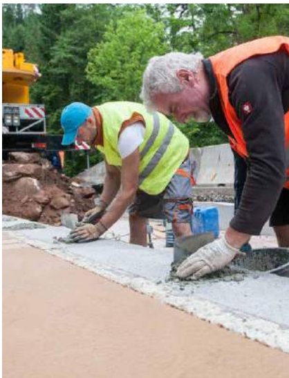
Herstellen von Mörtelkissen als Ausgleichsschicht
