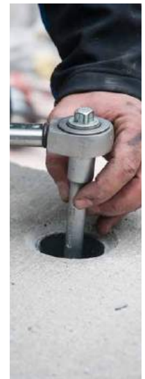
Verankerung des Fertigteils mit V4A-Klebe-Verbundankern. Die Verschraubung ist sofort belastbar.
