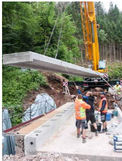
Versetzen der System-Brückenkappe mit dem Autokran
