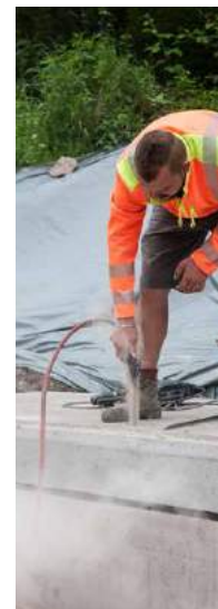
Verankerung des Fertigteils mit V4A-Klebe-Verbundankern. Die Verschraubung ist sofort belastbar.
