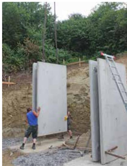
Die Hohlkammerwand zur Rückverankerung wird fertig angeliefert und auf das Fundament gesetzt.
