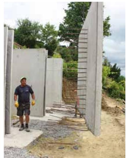
In der Hohlkammer verbinden sich die Bewehrungen des Fundaments und der fertig gelieferten Starwalls. Dann wird die Rückverankerung ausbetoniert.
