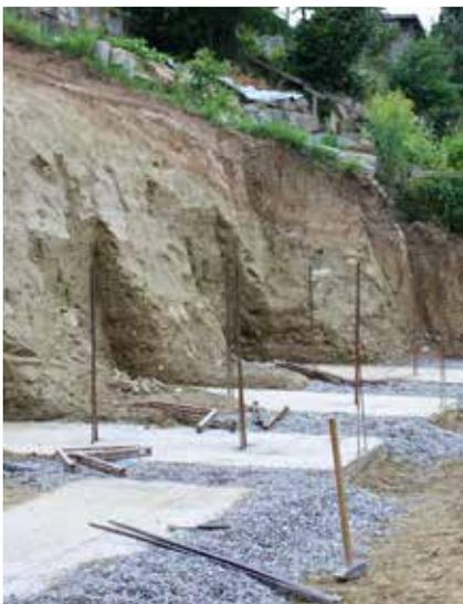
Bauseits ist ein punktuell Streifenfundament mit Anschlussbewehrung vorzubereiten.
