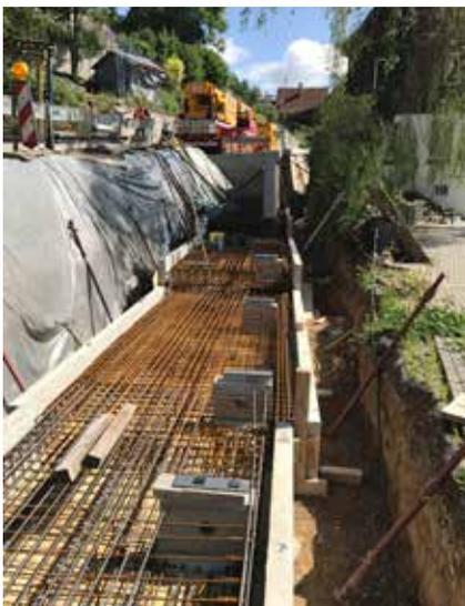
Das vorbereitete Fundament: Bewehrung und verlorene Schalungen aus Betonfertigteilen für die Sauberkeitsschicht in Ortbeton
