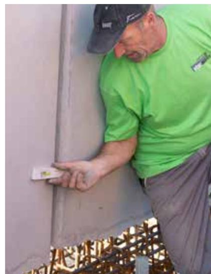
Ausrichten der Fertigteilwände in Höhe und Lage
