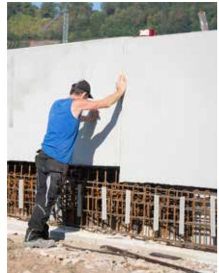
Versetzen der Fertigteilwände
