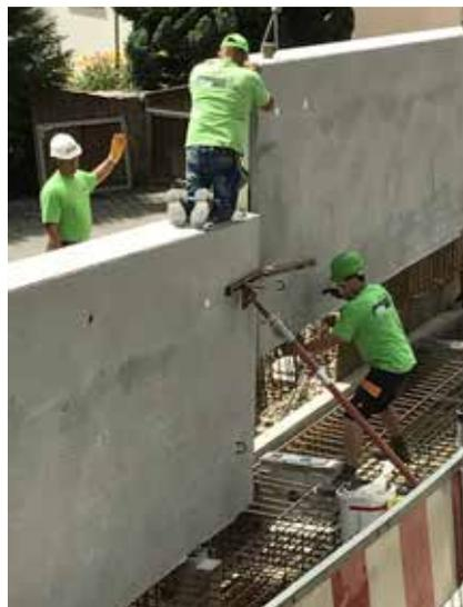
Wände werden auf die Betonsockel gehoben. Die Anschlussbewehrung der Wand greift in die Fundamentbewehrung.
