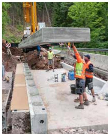
Versetzen der System-Brückenkappe als Fertigteil mit dem Autokran
