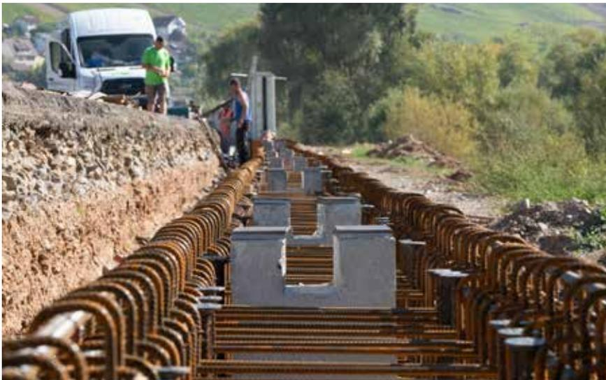
Bewehrungskorb Kopfbalken mit integrierten Stellklötzen für die FT-Wände
